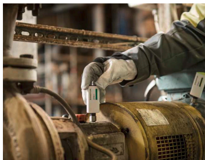
Montaż czujników OPTIME.
